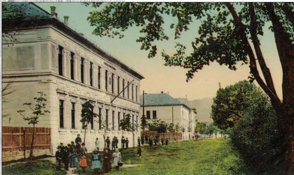
Budova štátnej ľudovej školy v Liptovskom Svätom Mikuláši, dnes Základná škola Miloša Janošku na Školskej ulici
